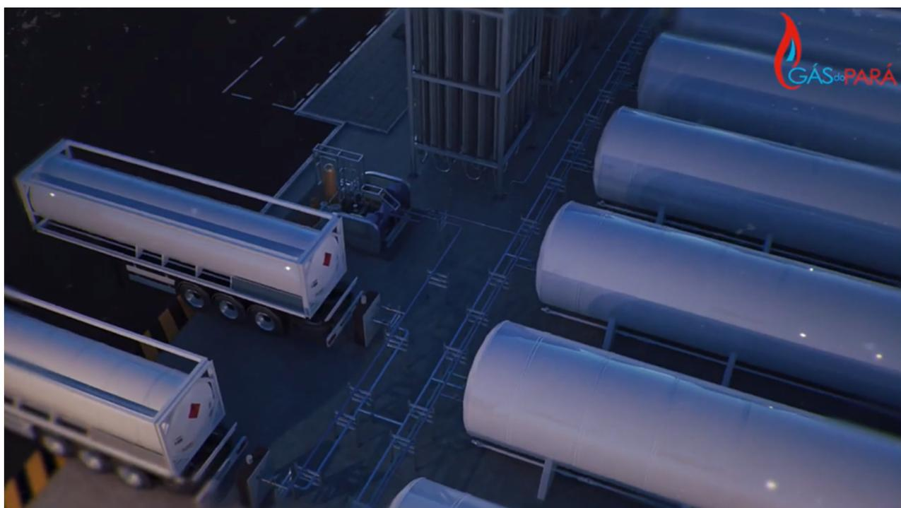
Nas estações, o gás será regaseificado, passando da forma líquida à forma gasosa. Este processo acontece por meio de equipamentos que fazem troca de calor com o próprio ambiente, sendo uma atividade limpa e totalmente livre de emissão de poluentes.
